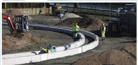
Einer der vielen Vorteile ist die komplette Herstellung der einzelnen Elemente im Betonfertigteilwerk. Auf der Baustelle selbst werden diese Elemente nur noch positioniert und über Verspannelemente zu einem geschlossenen, kraftschlüssigen Ringfundament verschraubt. Statisch ist die Fundamentierung nach dem Verspannen bereits voll belastbar.
